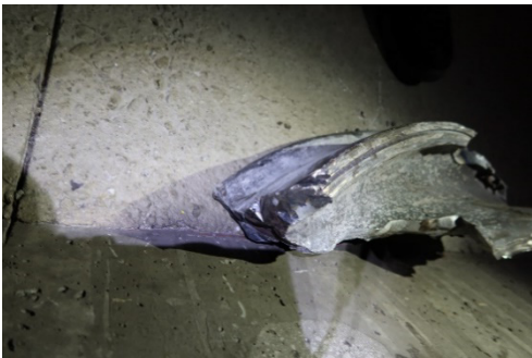
Figura 26: Frammento [8] all'altezza del km 40.50.
