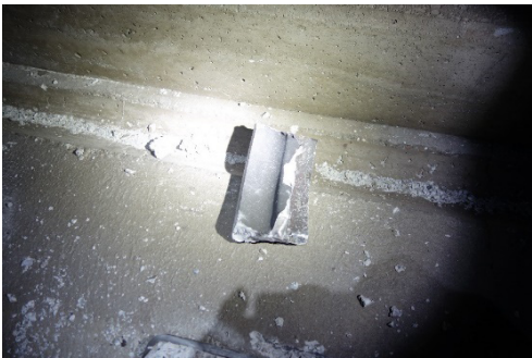
Figura 25: Frammento [7] all'altezza del km 46.70.
