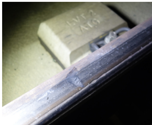
Figura 40: Altro segno sulla superficie di rotolamento della rotaia di destra in direzione di marcia (km 46.9–46.8).
