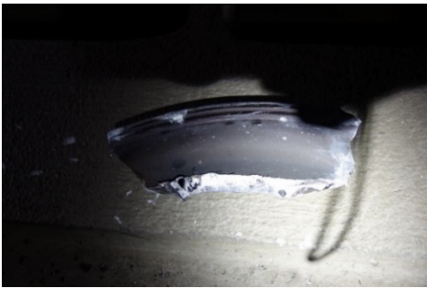
Figura 21: Frammento [3] all'altezza del km 46.93.
