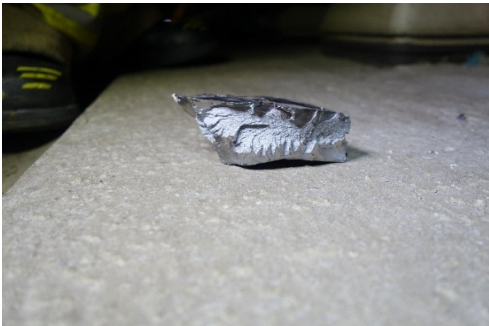
Figura 24: Frammento [6] all'altezza del km 46.77.
