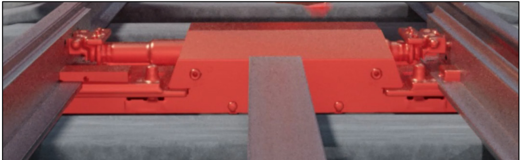
Figura 62: Scambio Hydrostar, chiusura di punta.
